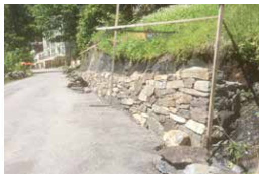
Rosenloui Mauer: Der erste Deckstein ist gelegt
