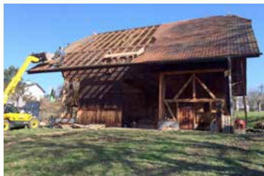
Schopfabbau in Bolligen
